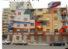
Rekonstrukce bytových domů v Tiraně (Albánie) [19]
